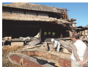
図 6-24 資材調達(古民家解体) (2020. 11. 4)
