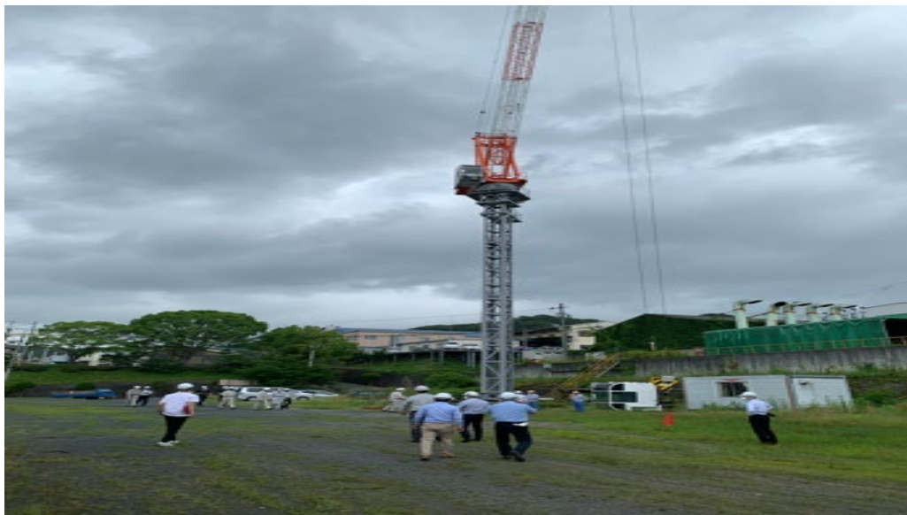
写真 遠隔操作クレーン調査
