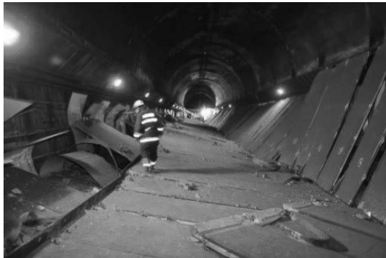
図4 笹子トンネル事故（2012年12月） （日経XTECHより）
