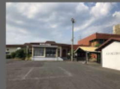
卸町センター
