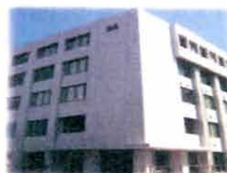
薬学棟側から見た34号館
