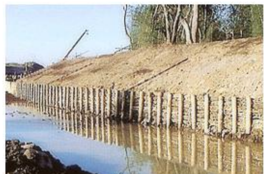
柵工法と柵工法により整備された護岸
