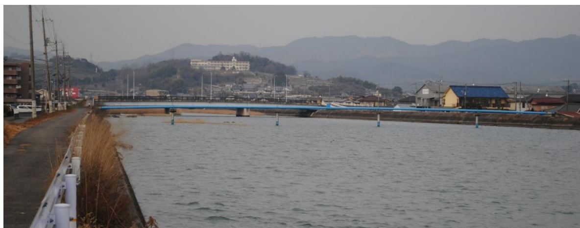
写真 1.2.1 海側より見た今津小学校遠景
