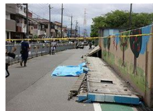
大阪北部地震で倒壊した 高槻市小学校のブロック塀
